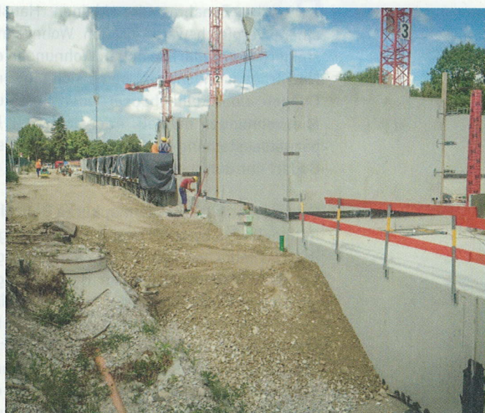
Die Beton-Oberflächen sind dank automatisierter Fertigung von hoher Qualität.
