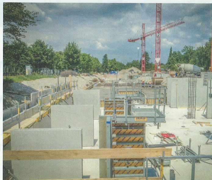
Die Doppelwand-Elemente werden nach dem Aufbau ausgegossen.
